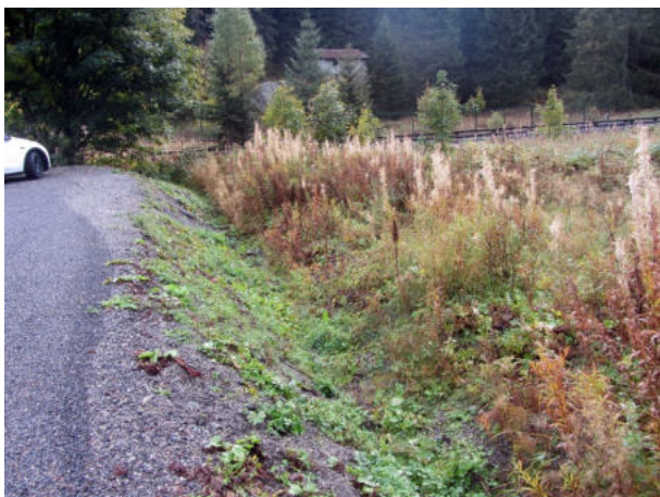
Fossé en pied de remblai du parking actuel
